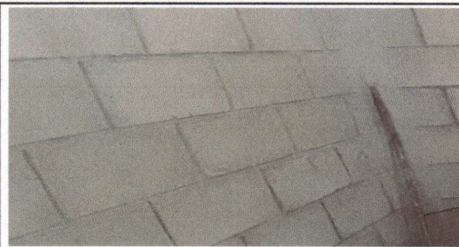
Foto 9: Sustitución de azulejo.
