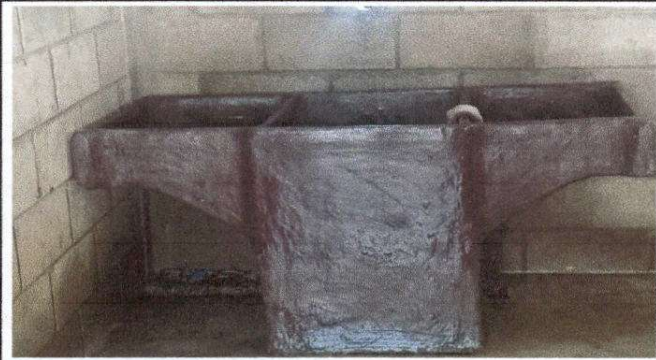
Foto 14: Sustitución de pila de cemento de dos lavaderos.
