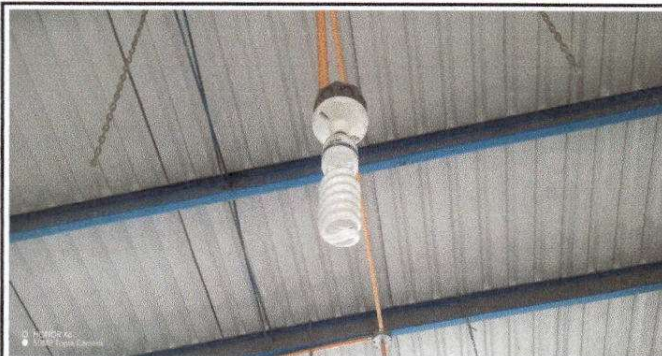
Foto 12: Sustitución de lamparas tipo LED.
