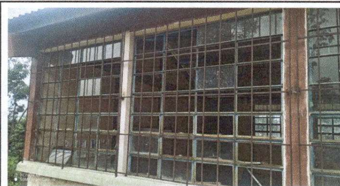
Foto 3: Mantenimiento estructura de metal de ventana, sustitución de vidrios, mantenimiento a balcones de metal.
