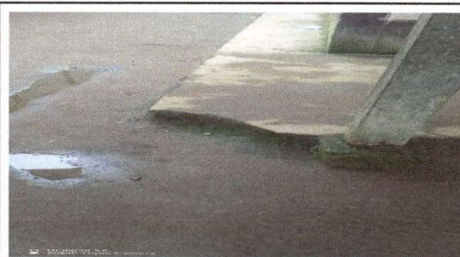
Foto 4: Reparación de piso de torta de concreto.
