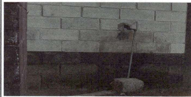
Foto 10: Sustitución de tubería PVC línea principal aguas negras.
