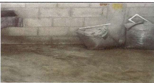
Foto 6: Sustrucción de Piso cerámico.
