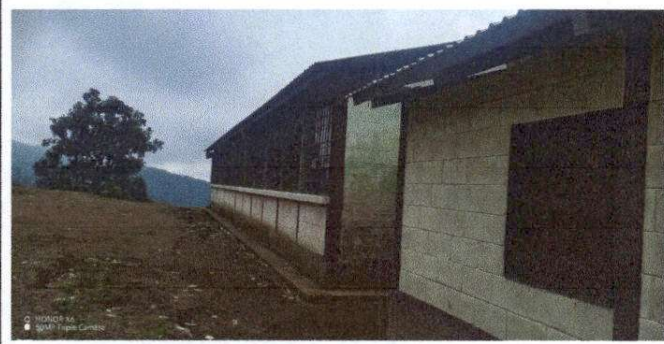
Foto7: Pintura en muros exteriores e interiores.
